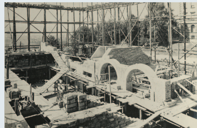
Sommer 1911, Blick Richtung Stadtzentrum: Die Rundbögen des Vestibüls werden auf das betonierte Fundament gemauert. Sie bilden den Eingangsbereich des Biologiegebäudes (heute KO2) mit dem Zoologischen und dem Paläontologischen Museum.
