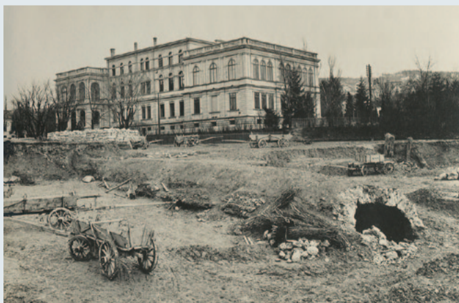
Das geräumte Grundstück für die neue Universität. Beseitigt werden mussten die Blinden- und Taubstummenanstalt und das Städtische Gefängnis. Gebaut wurde mit einfachsten Mitteln: mit Pferdewagen, Flaschenzügen und Holzgerüsten.
