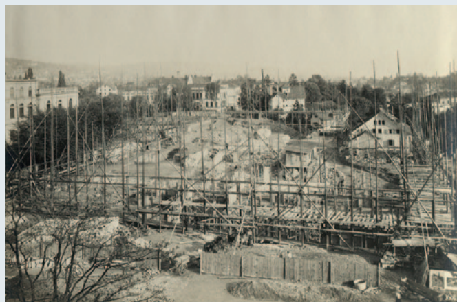
Das ausgehobene Baufeld: Links die ehemalige Augenklinik, heute Heimat des Archäologischen Museums und des Kunsthistorischen Instituts, gesehen von der ETH. Der Spatenstich erfolgte am 3. Januar 1911. Die Bauarbeiten schritten rasch voran.
