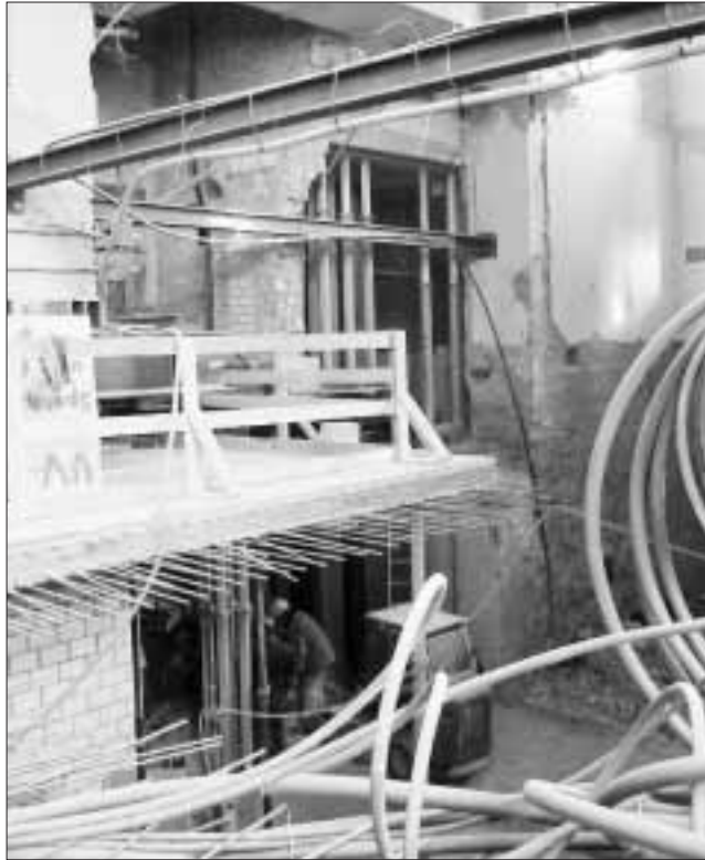
Verschlungene Pfade: Wo noch bis vor kurzem die provisorische Metalltreppe vom Hauptgebäude in die Mensa hinunterführte, kreuzen sich die Baustellen für die Mensa und den unterirdischen Hörsaal.
