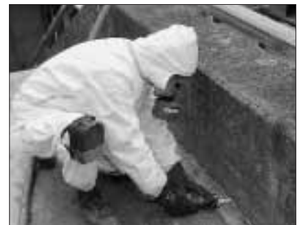
Die PCB-Fugensanierung an der Mensa ist eine giftige Angelegenheit. (Bilder zVg)
